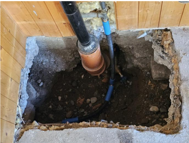
Schaden Wasserzuleitung
